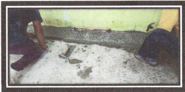
Colocación de piso de granito INEB Telesecundaria El Pato.
